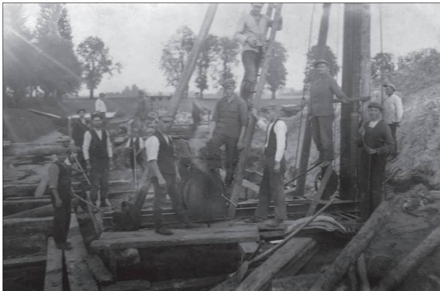
Budowa mostu żelbetowego na Samicy na drodze powiatowej Śmigiel – Stare Bojanowo w 1928 roku
